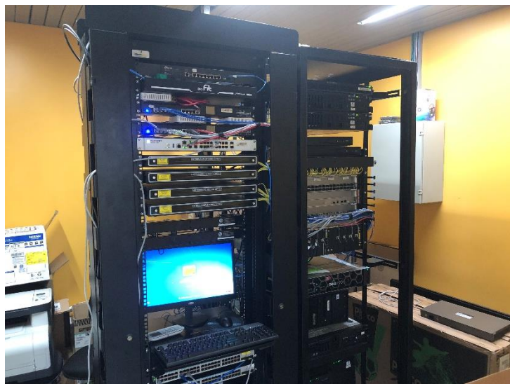
Imagem 07 – Sala do Datacenter
